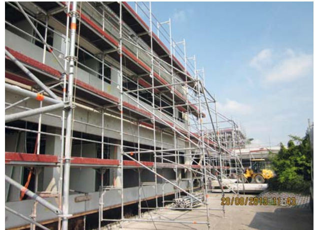
Gerüst mit fachgerechter Abstützung
